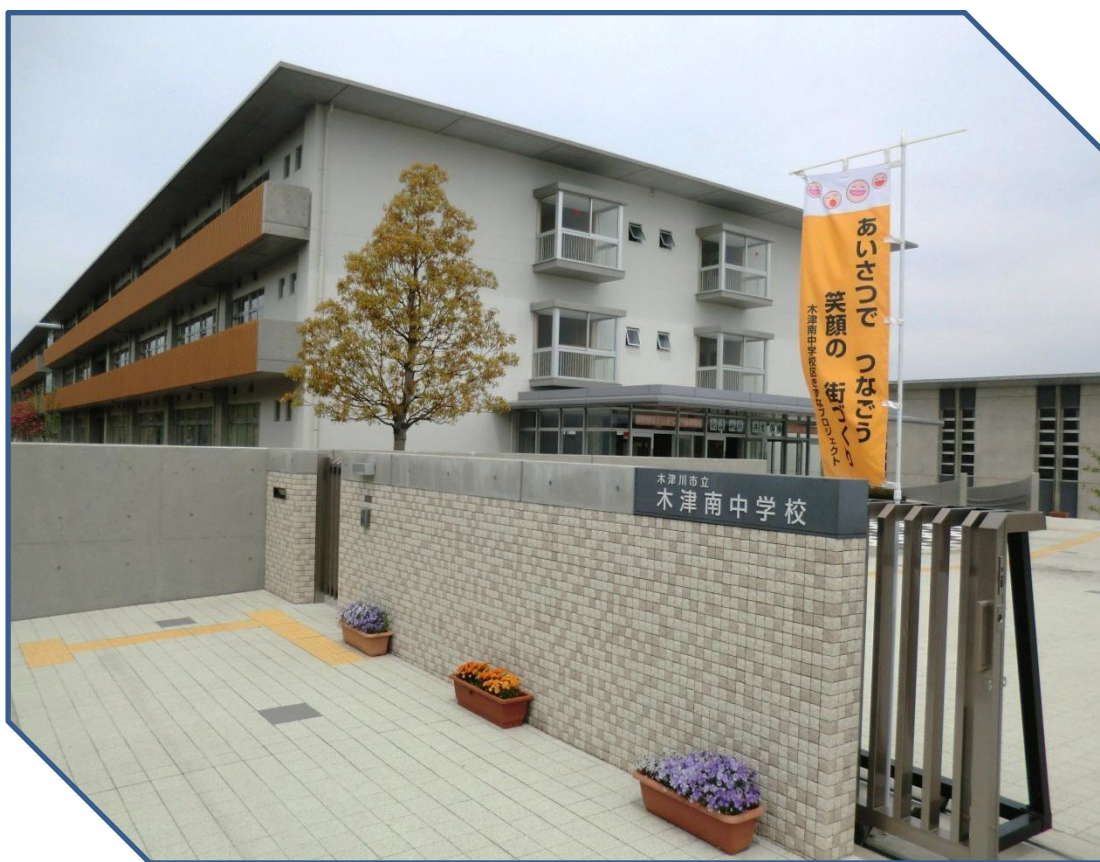
木津川市立木津南中学校
